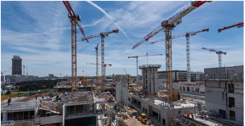
Chantier de construction du Village Olympique et Paralympique
